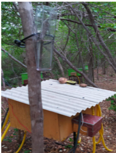
Figura 5 - Centro de comando e controle do apiário experimental instalado no sítio Cachoeira Alta Fonte: Autor (2021)
