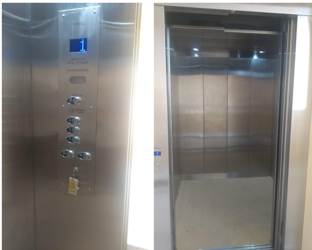
Figura 6: Instalação do elevador social no educandário, conforme a NBR 9050.
