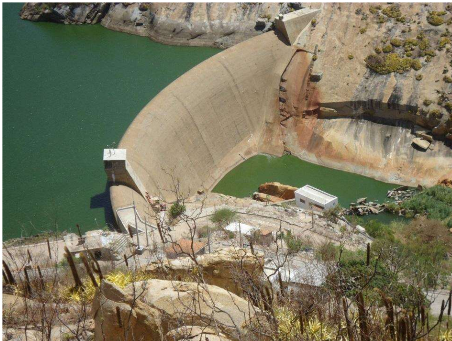
Figura 43: Barragem do tipo arco-gravidade. Barragem Gargalheiras, Acari/RN.
