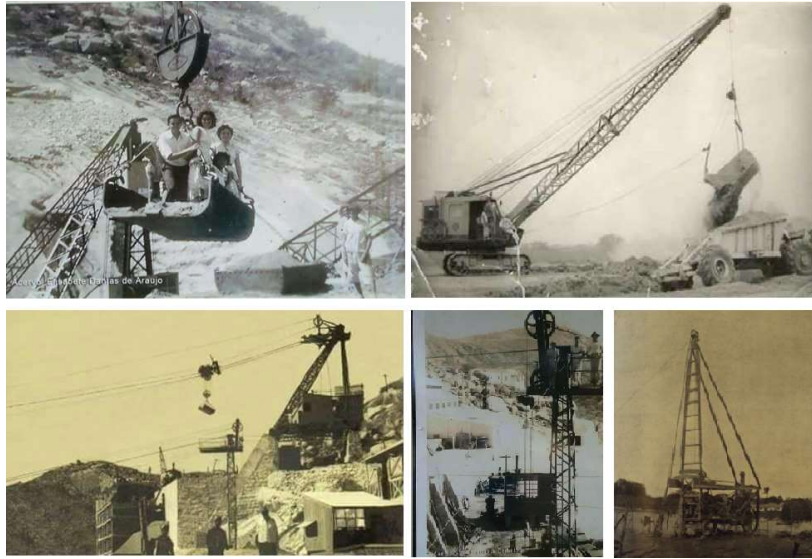
Figura 26: Guindastes e perfuratrizes usados durante as obras.
