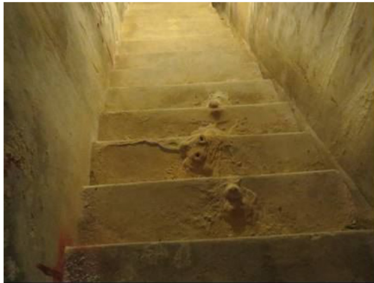
Figura 51: Formação de estalagmites na escadaria da galeria.
