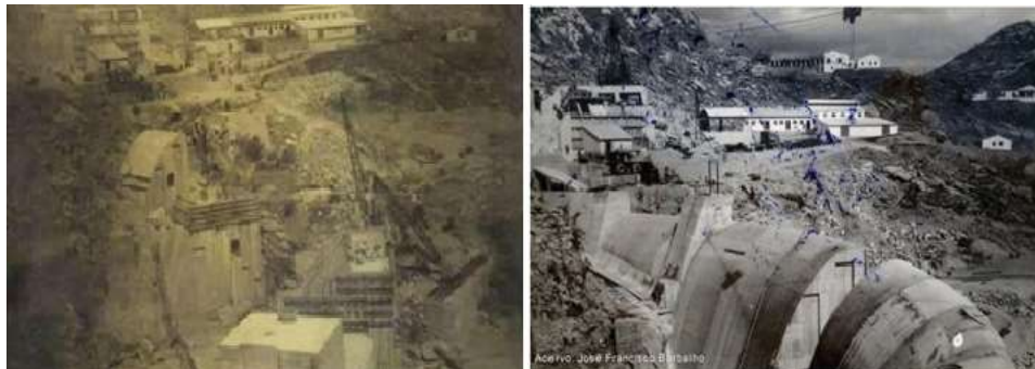
Figura 27: Visão panorâmica do canteiro de obra.
