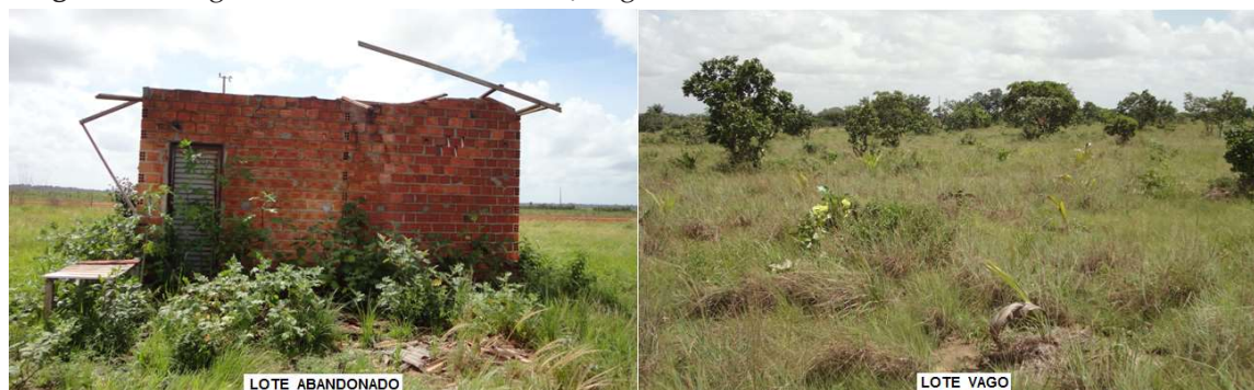
Figura 5 - Imagens dos lotes abandonados/vagos no assentamento Santo Antônio da Pedreira.
